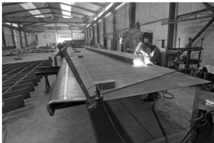
Un soldador trabaja en el montaje de una pasarela en Pamplona.
