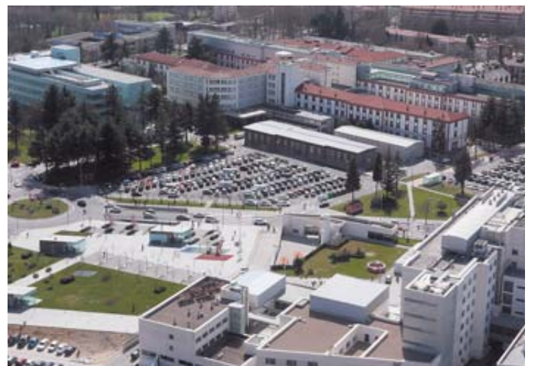
Vista aérea del Complejo Hospitalario de Navarra.
