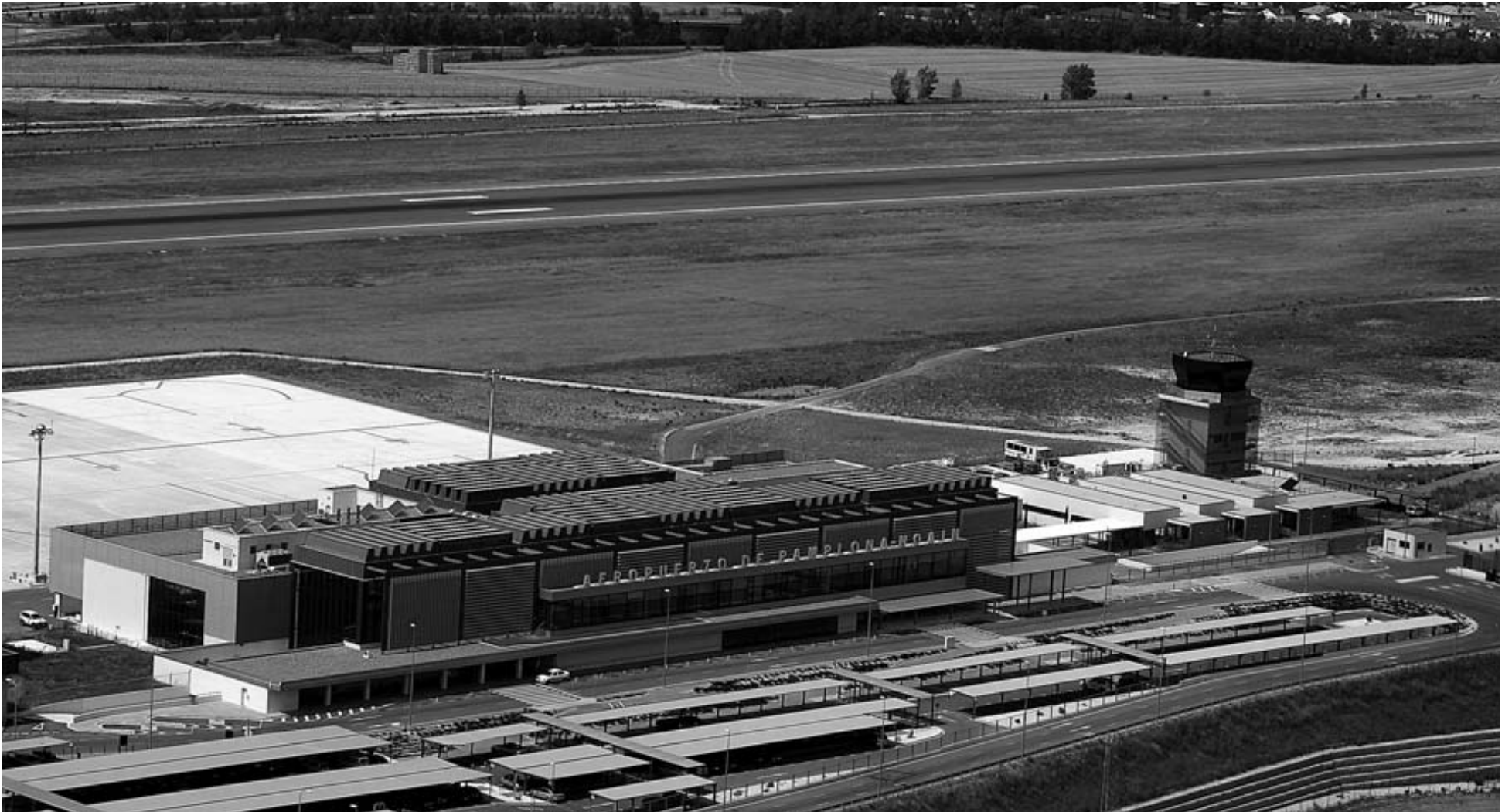
Nueva terminal del aeropuerto de Noáin-Pamplona. En las obras de remodelación del aeropuerto se gastaron 44 millones en los últimos años.
