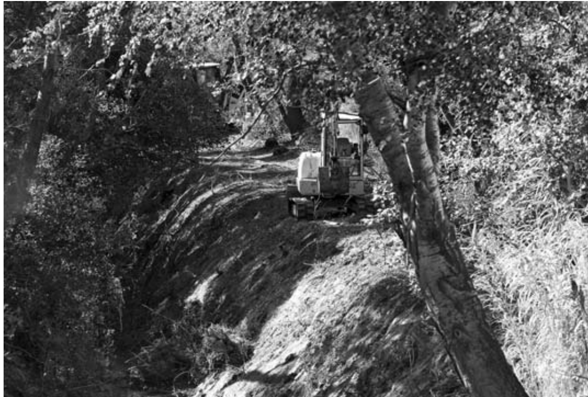
Lugar donde falleció Miguel Ángel Sola, con la excavadora en la parte alta del cauce.
