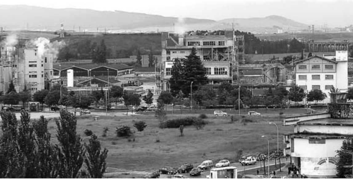
Instalaciones de Inquinasa en el barrio pamplonés de Echavacoiz.
