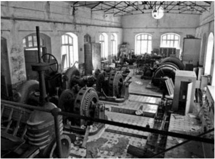
Interior de la vieja central hidroeléctrica de Aoiz. ASER VIDONDO
