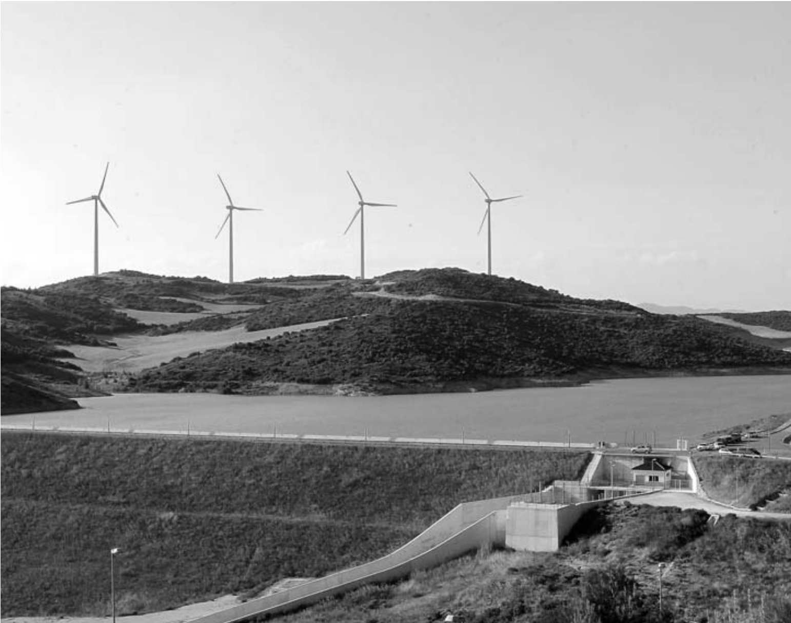
Balsa de regulación del Canal en Artajona, donde se iniciará el ramal hacia Tierra Estella.
