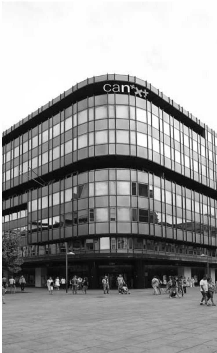
Vista de la antigua sede central de la CAN en Carlos III.
