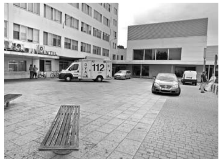
Edificio de urgencias infantiles. Detrás se ubicará la nueva cocina ARCHIVO
