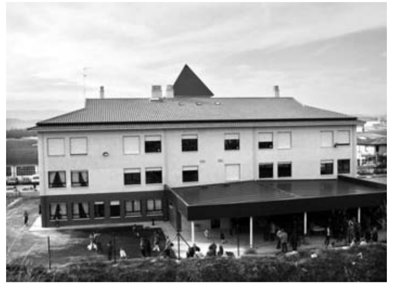
Vista del edificio de la ikastola Ibaialde de Lodosa.
