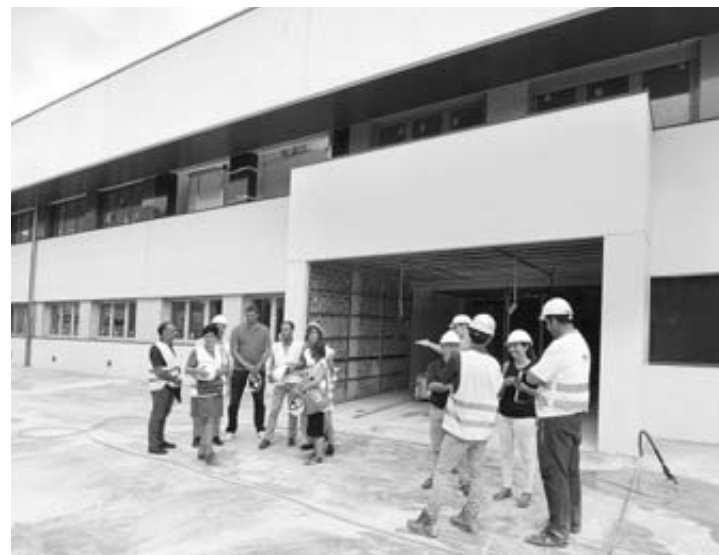
Estado actual de las obras en el nuevo instituto de San Jorge.
