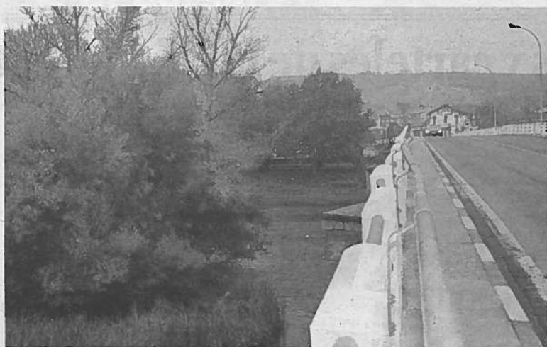
Barandilla que han colocado en el puente que cruza el río. FOTO: MARÍA SAN GIL
