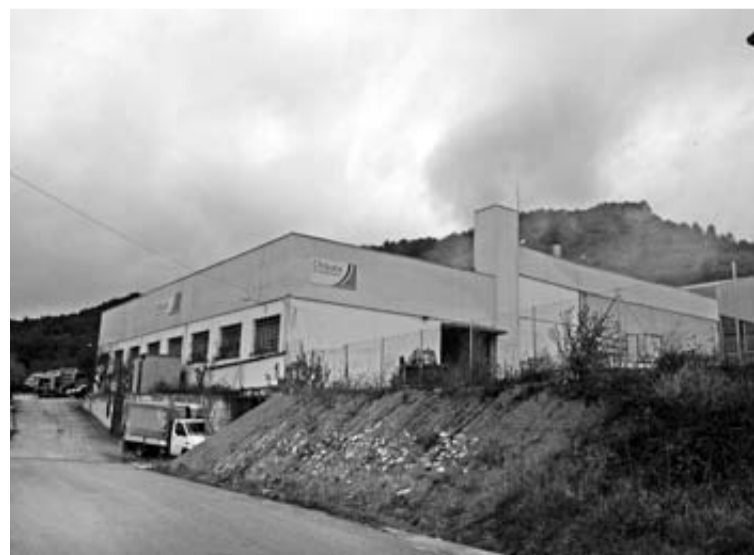
Las instalaciones de Chipala con el fuego ya sofocado.
