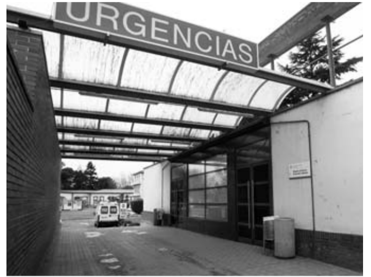
Acceso de Urgencias del Centro Hospitalario de Navarra. GOÑI (ARCHIVO)
