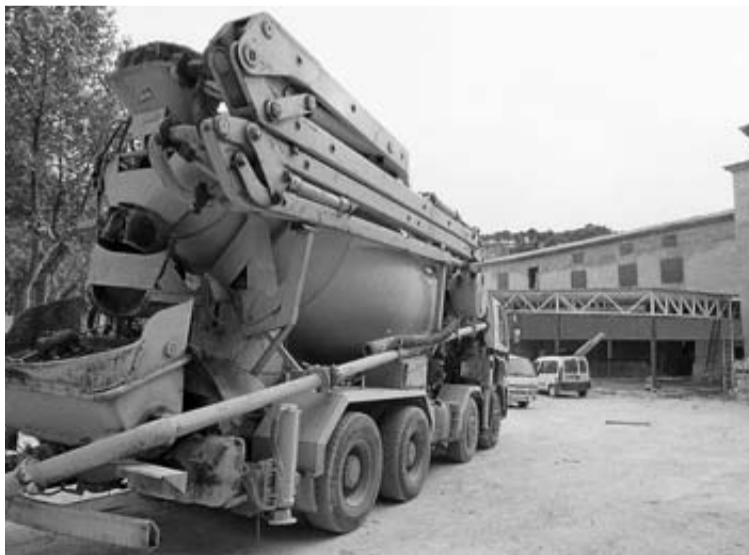
Un camión hormigonera en una obra, en una fotografía de archivo.
