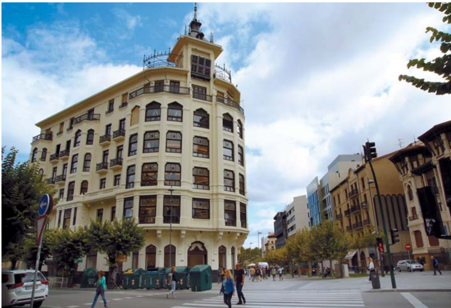
La reubicación de Zara en el antiguo edificio de La Vasconavarra ha revolucionado la situación comercial de la calle Roncesvalles.
