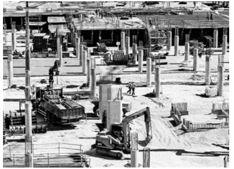
Empleados de la construcción, en una obra en Madrid.
