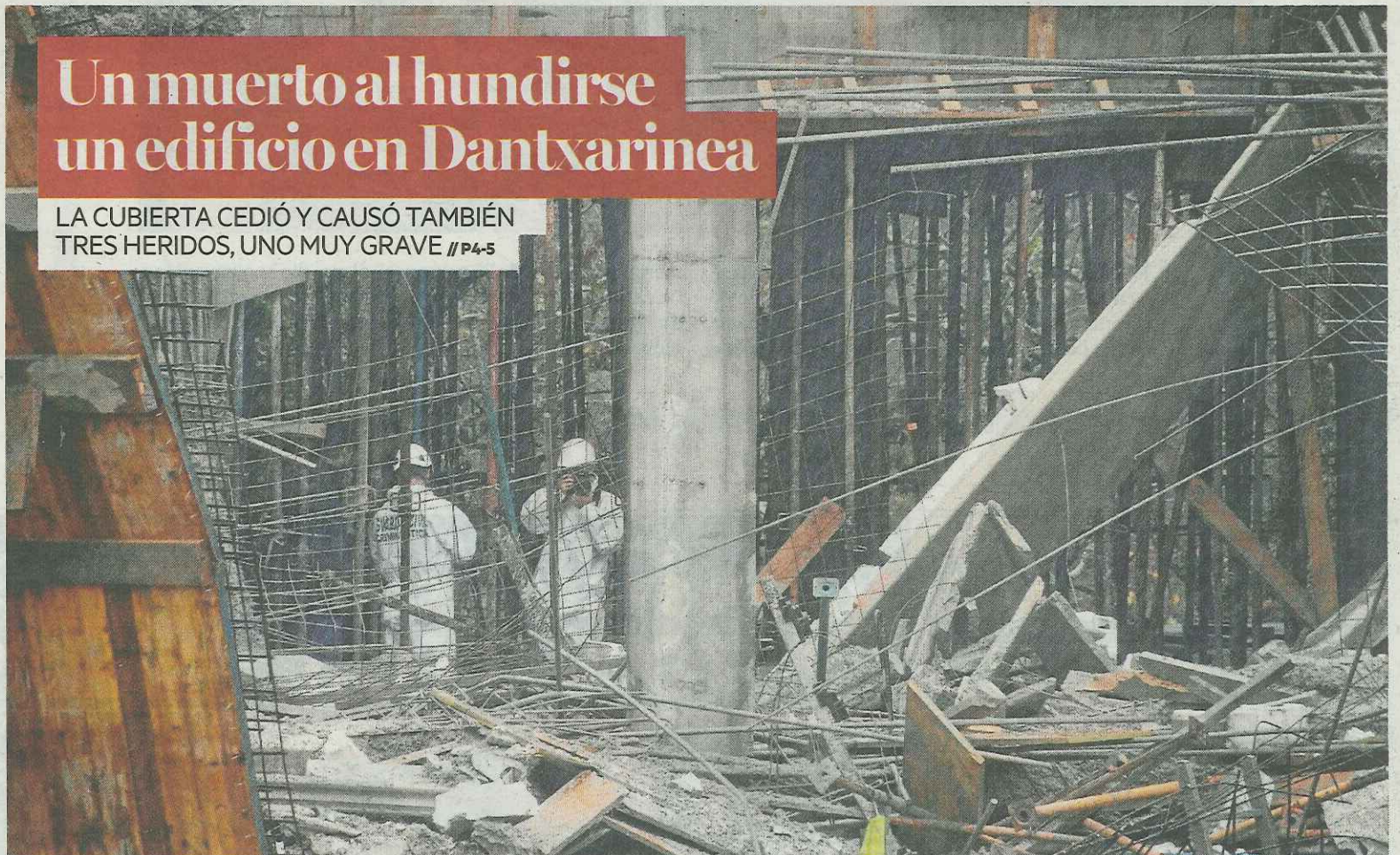
El material de la cubierta cayó sobre la planta inmediatamente inferior. Foto: Ondikol
