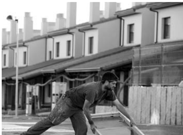
Viviendas en construcción de Martinasa-Fadesa en Galicia.
