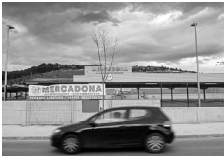
El supermercado comenzó a construirse a finales de enero y ya está casi listo en tiempo récord. MONTXO A.G.
