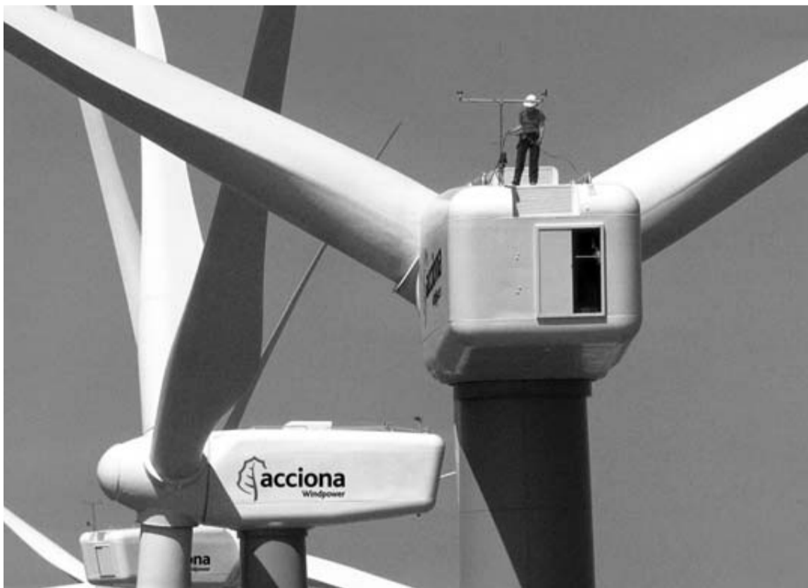
Un operario trabaja en el mantenimiento de un aerogenerador.
