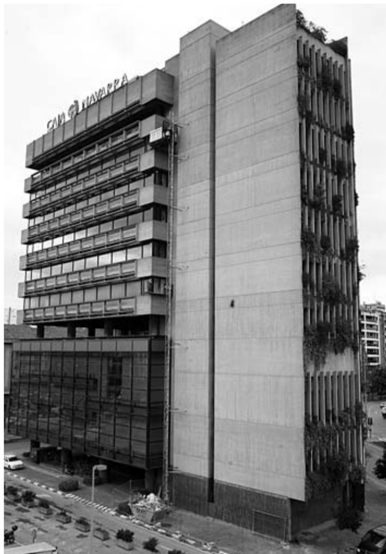
Imagen de archivo del edificio que fue la sede de Caja Municipal. CORDOVILLA
