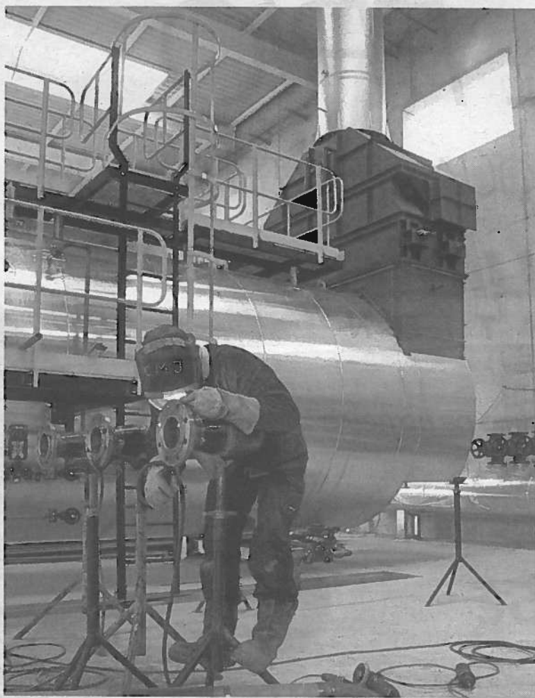
Operario en tareas de montaje en la Ciudad Agroalimentaria. FOTO: F. P.-N.
