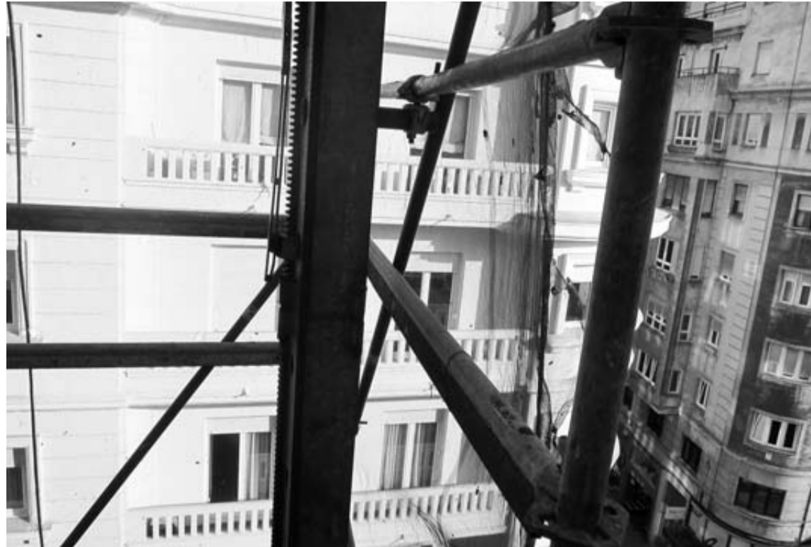
Un edificio del centro de Santander en rehabilitación.
