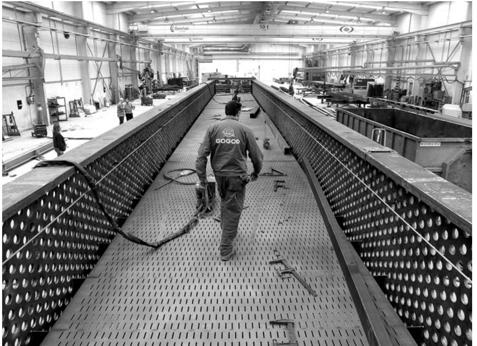
Pasarela en construcción en la empresa Gogor en el Polígono de la Comarca 2.
