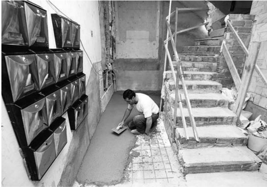
Obra para la eliminación de barreras arquitectónicas en un portal.
