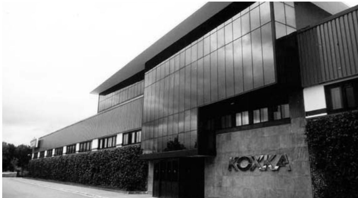
Acceso a la planta de frío industrial en el polígono de Landaben.
