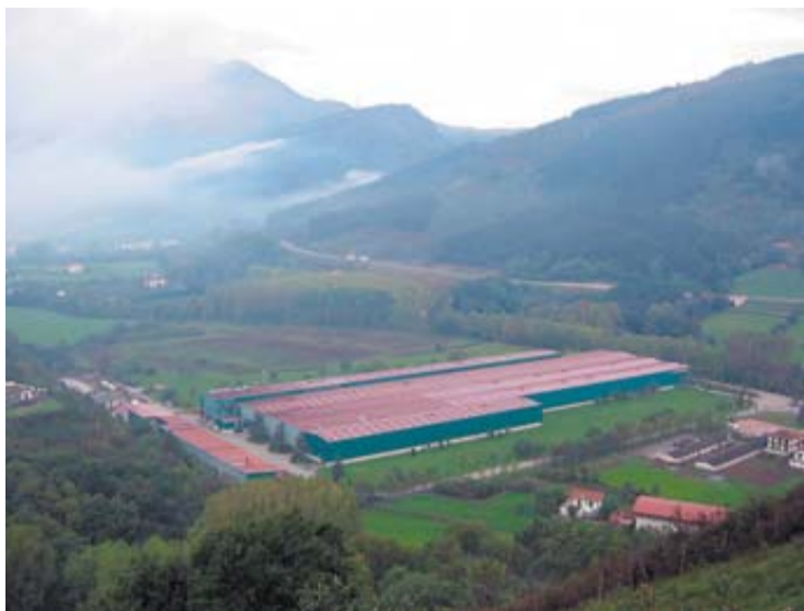
Panorámica de las instalaciones de Arcelor Mittal en Legasa. ARCHIVO
