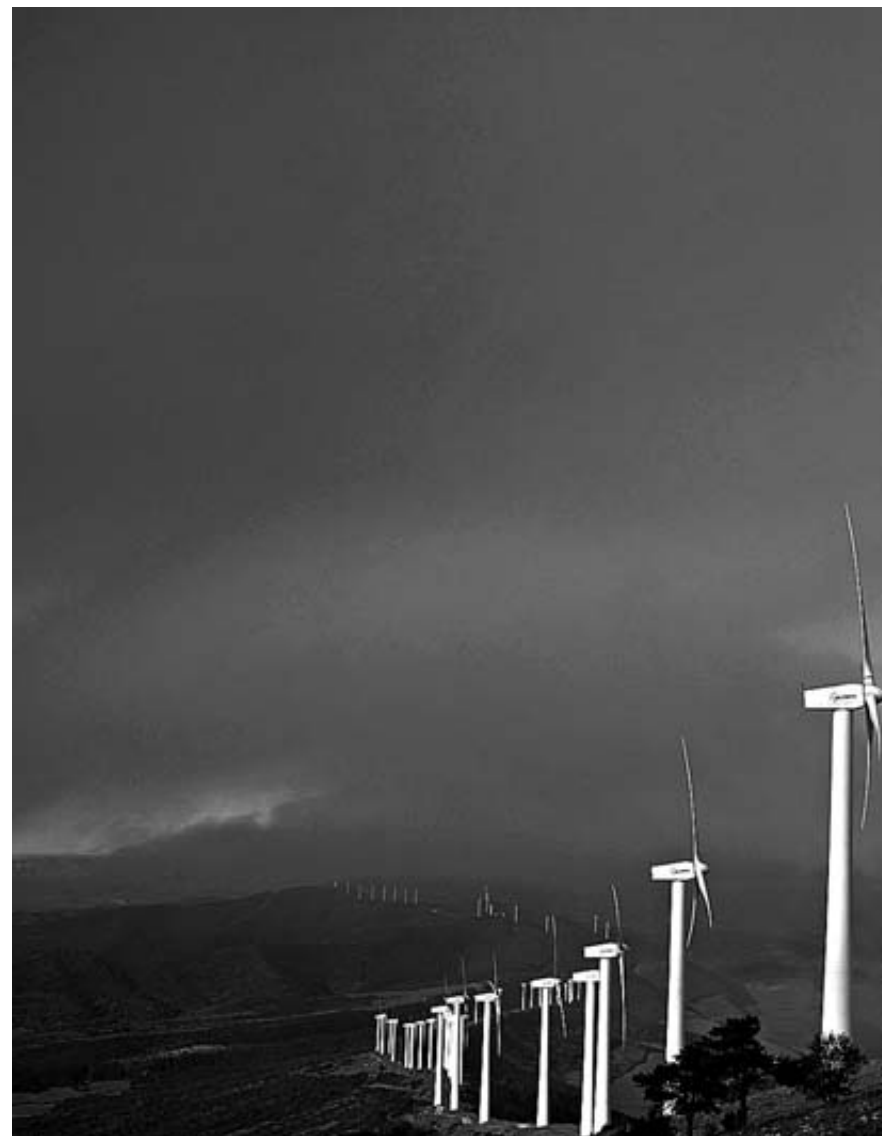
Panorámica del parque eólico de El Perdón.
