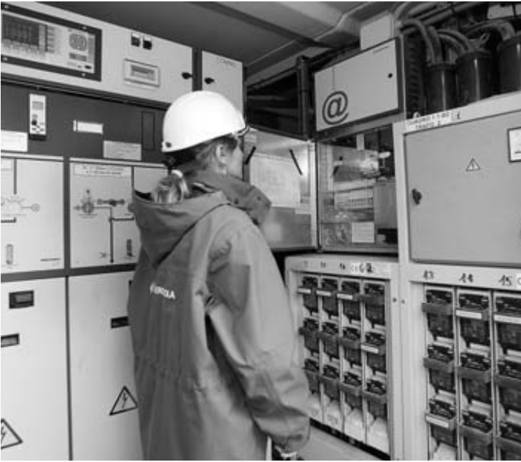
Uno de los centros de transformación que se han renovado para leer los datos de los nuevos contadores
