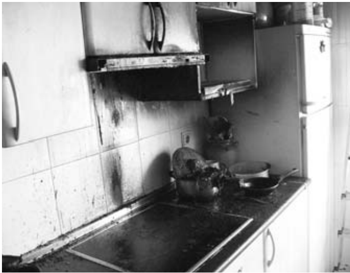
El fuego se originó en la cocina de la vivienda.
