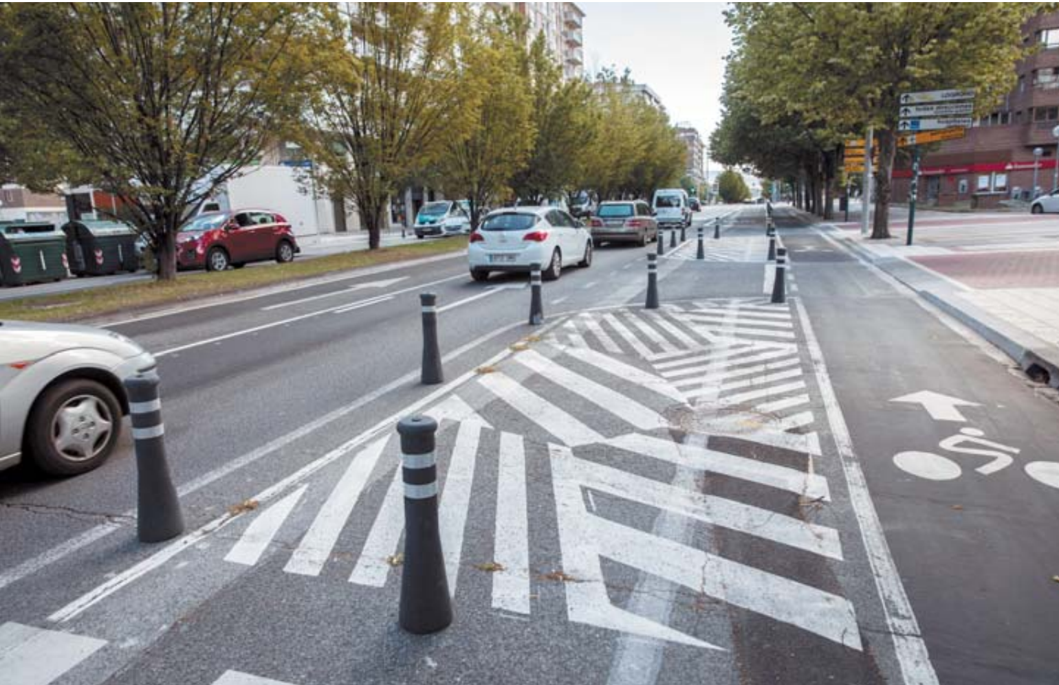
En la llamada banda multifuncional, ahora rodeada de bolardos, se van a recuperar unos 66 aparcamientos en Pío XII tras las obras. JESÚS CASO
