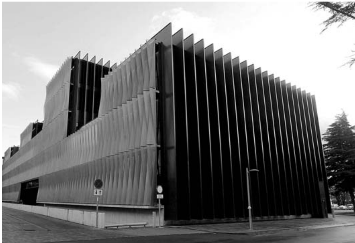
Edificio del centro de investigación Navarrabiomed (CIB), sede del laboratorio LUNA.
