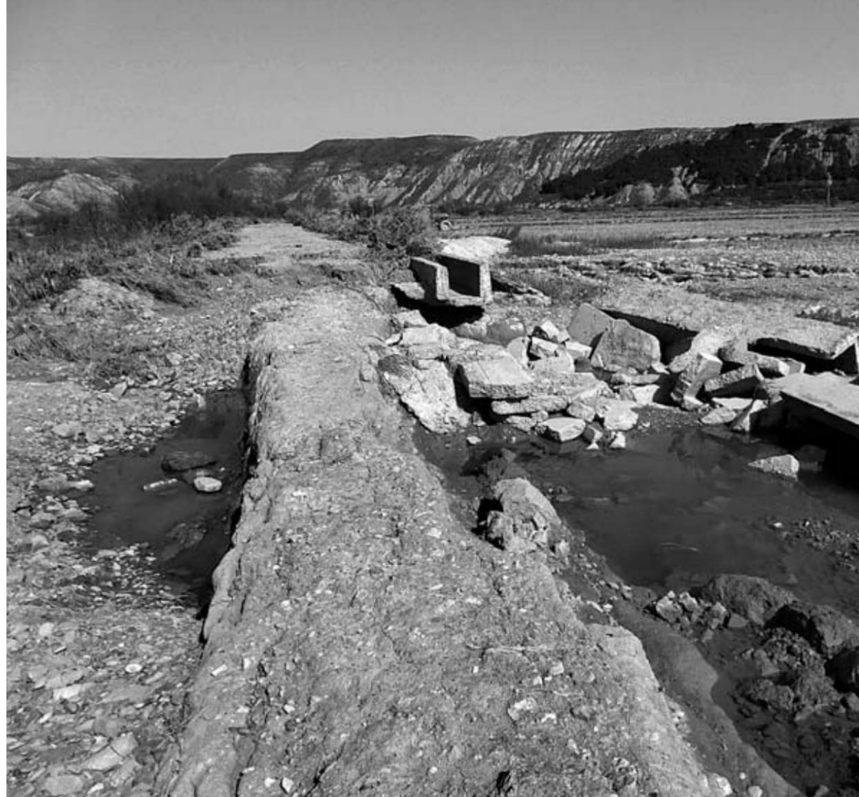
Imagen de una explotación agraria tras las inundaciones. En primer plano, una acequia destruida por la fuerza
