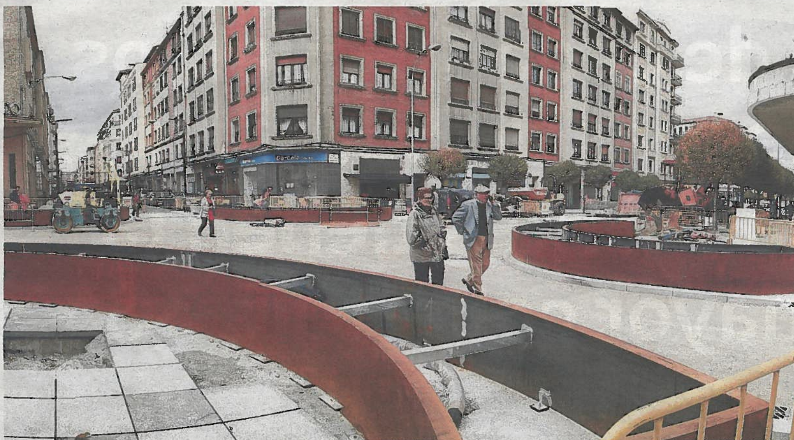
Estado de las obras de urbanización junto al Mercado del Ensanche. FOTO: PATXI CASCANTE
