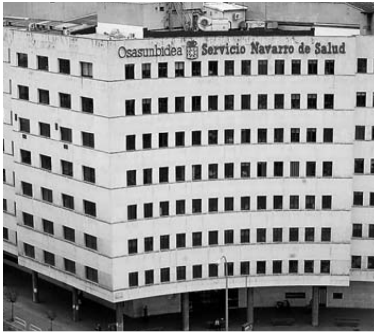
Imagen de uno de los edificios del SNS.
