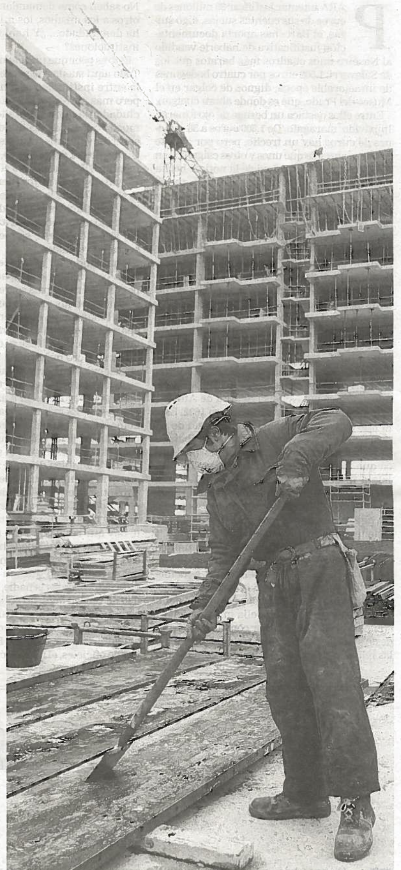
Un obrero durante la construcción de una vivienda. FOTO: J. BERGASA
