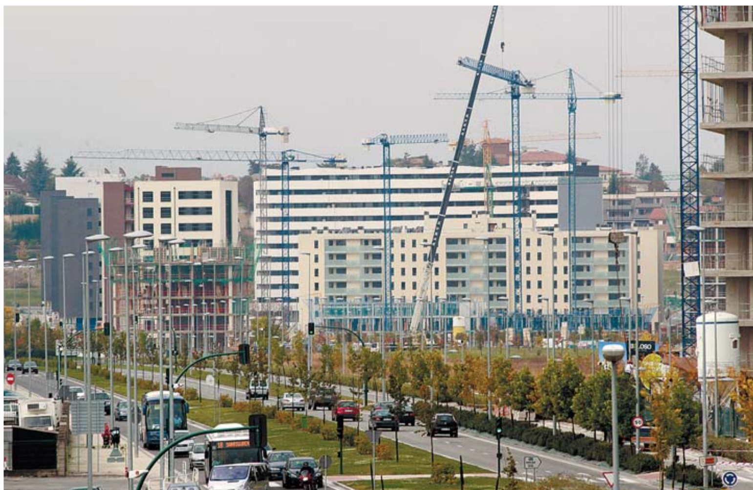
Imagen de viviendas en construcción en la nueva zona urbana de Erripagaña.
