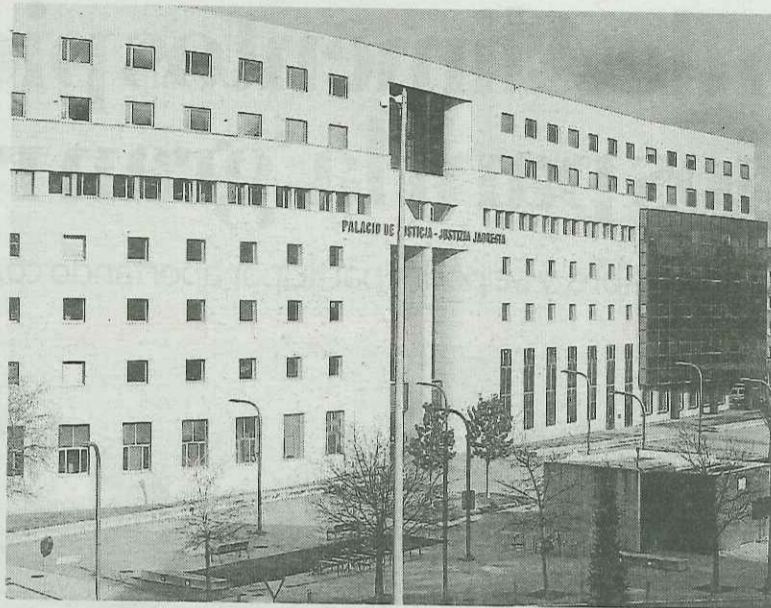
Fachada del Palacio de Justicia de Navarra. Foto: Patxi Cascante
