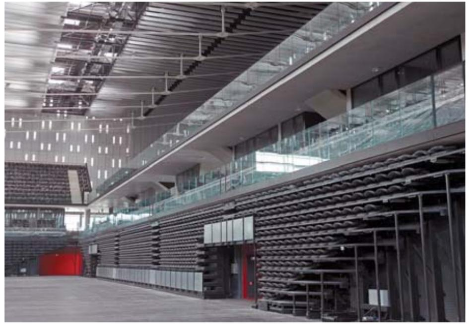
Parte de las gradas retráctiles del pabellón para ampliar el aforo. DN
