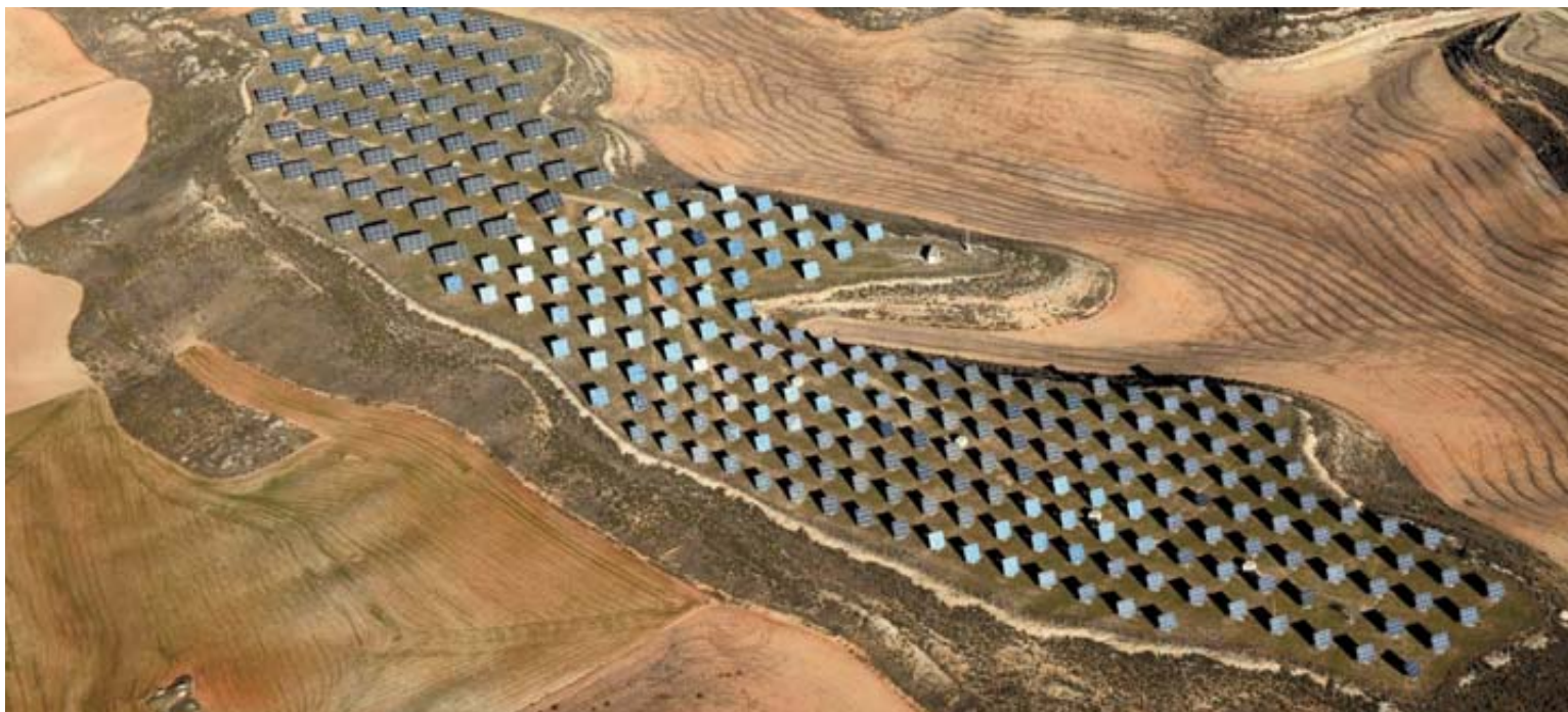
Panorámica del parque solar de Ríos Renovables levantado en Cabanillas.
