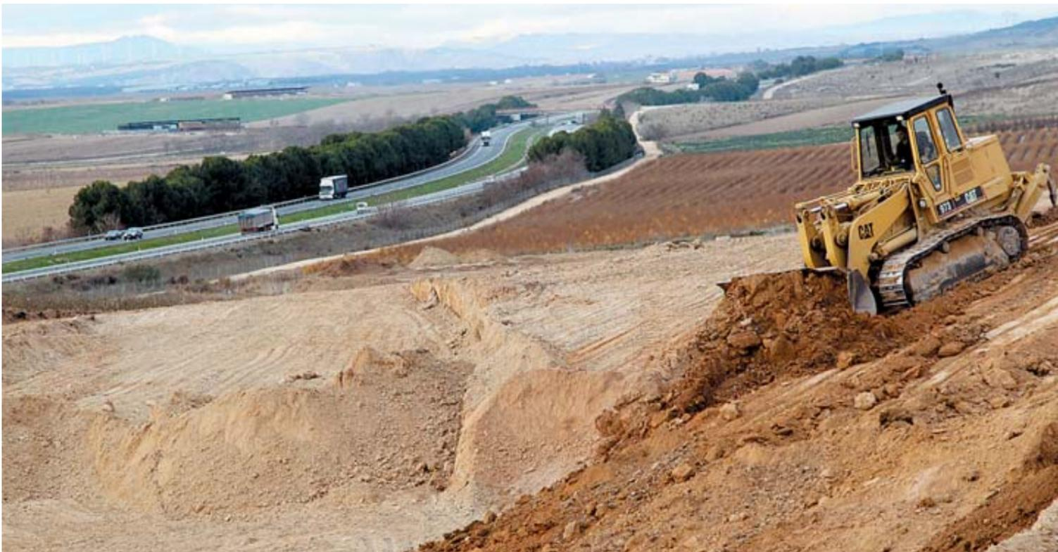
Una máquina trabaja en la construcción de la plataforma del tren en el tramo Castejón-Villafranca.
