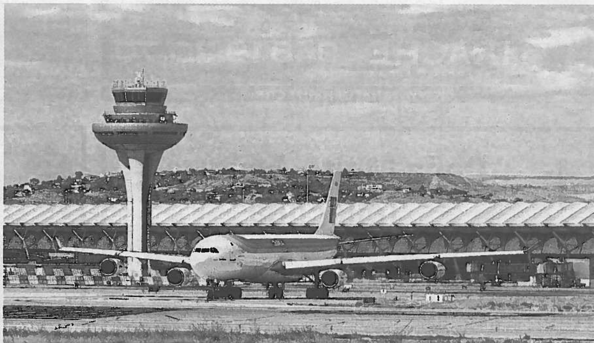
Un avión de la compañía Iberia en la Terminal 4 del aeropuerto de Barajas. FOTO: E.P.
