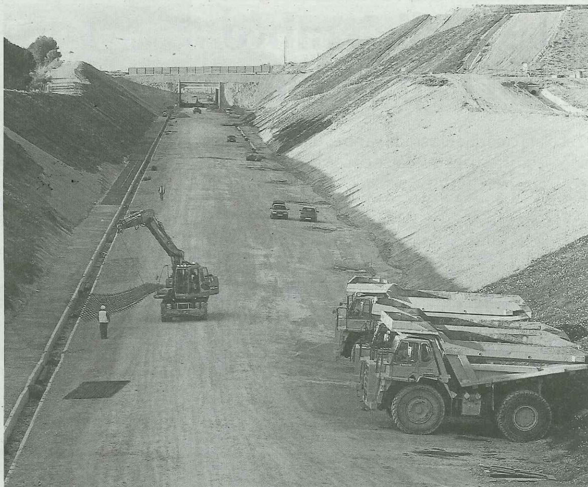
Obras de la alta velocidad en el subtramo Castejón-Cadreita, en un punto cerca de Valtierra. Foto: Javier Bergasa
