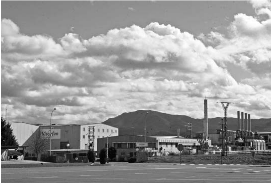
Imagen de las instalaciones de Viscofán en Cáseda.
