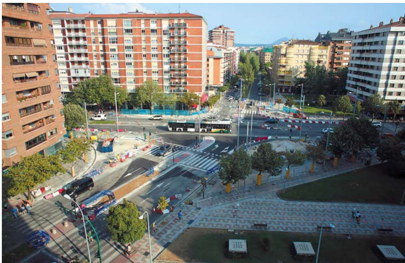
Aspecto de la rotonda tras las obras de transformación en la avenida.
