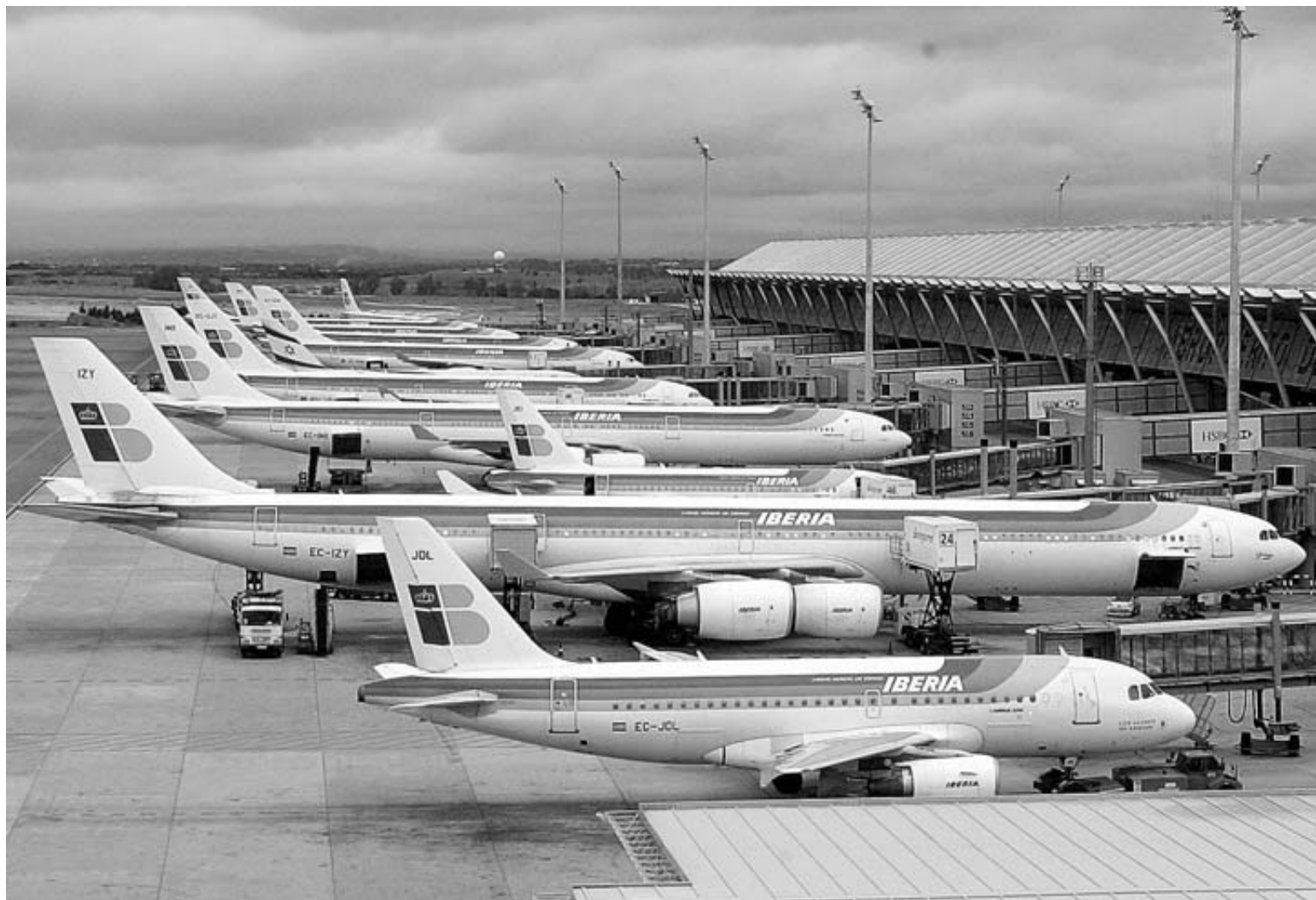
Vista exterior de la T-4 del aeropuerto de Barajas, una de las infraestructuras más importantes de la red de AENA.
