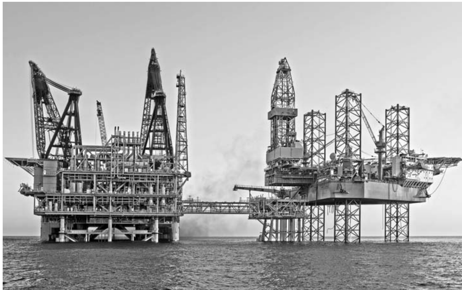
La plataforma construida sobre el almacén subterráneo en la costa de Vinarós (Castellón).
