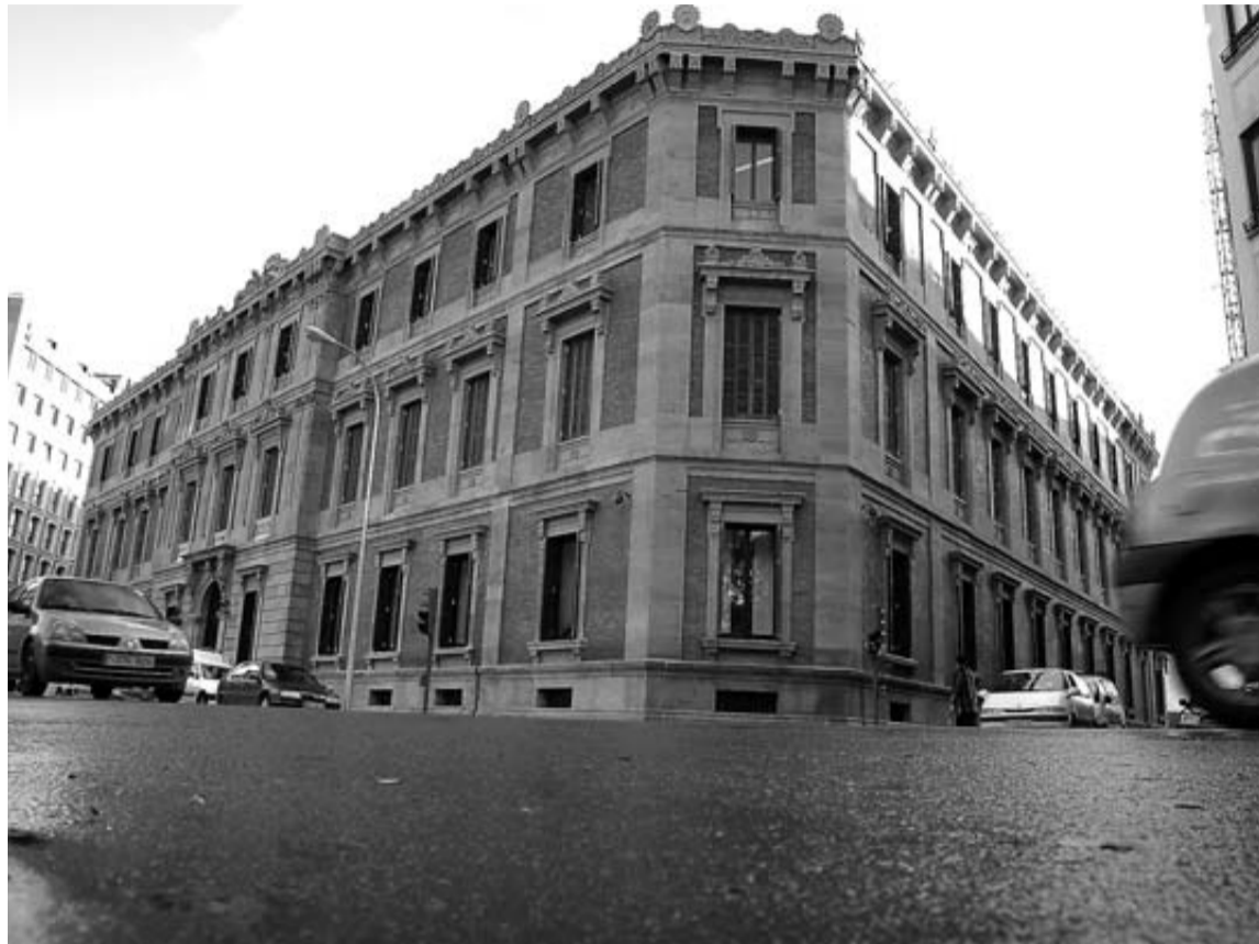
En la imagen, la fachada de la sede del Parlamento de Navarra.
