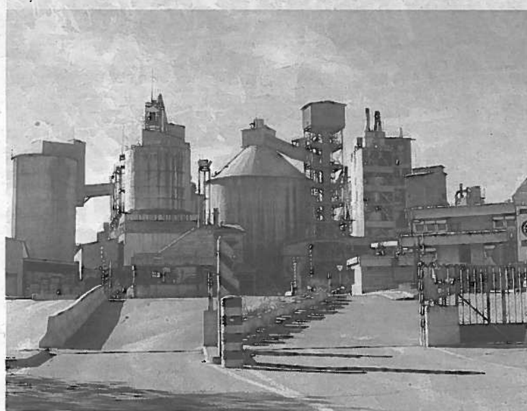
Aspecto exterior de la planta de Portland en Olazti. FOTO: N.M.
