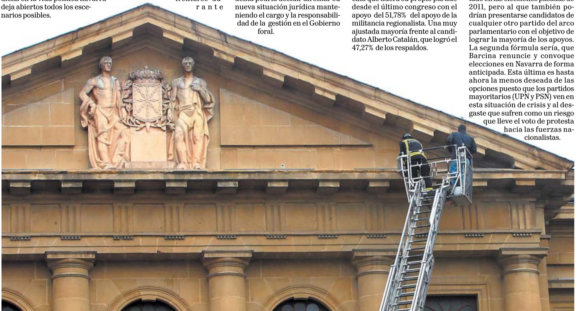
Dos operarios reparan uno de los aleros del frontispicio del Palacio de Navarra, sede del Gobierno foral.
