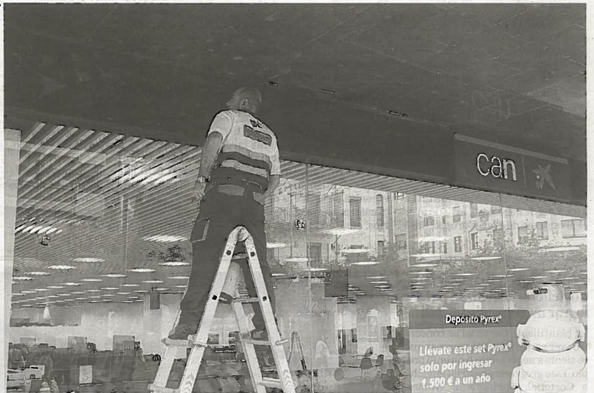
Un operario coloca los rótulos de CaixaBank en Pamplona. FOTO: UNAI BEROIZ
