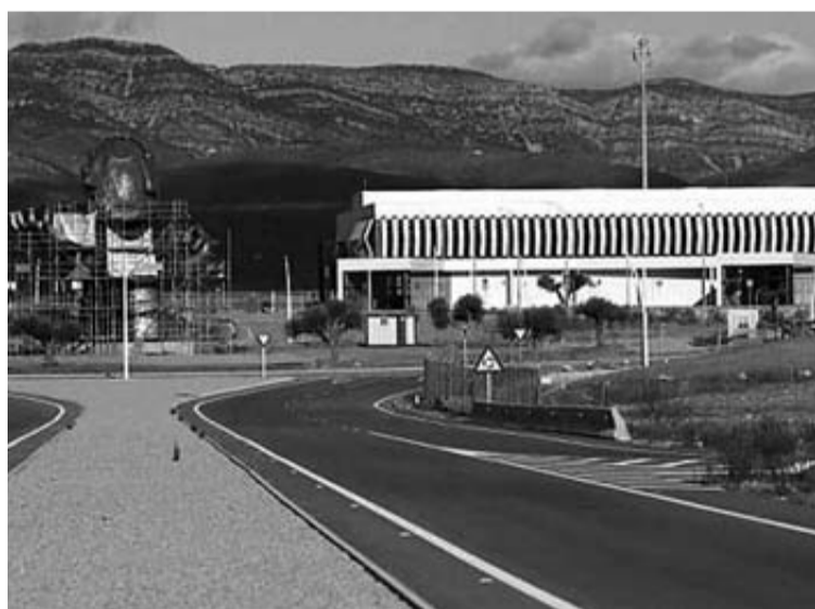
Aeropuerto de Castellón, sin tráfico aéreo en la actualidad.
