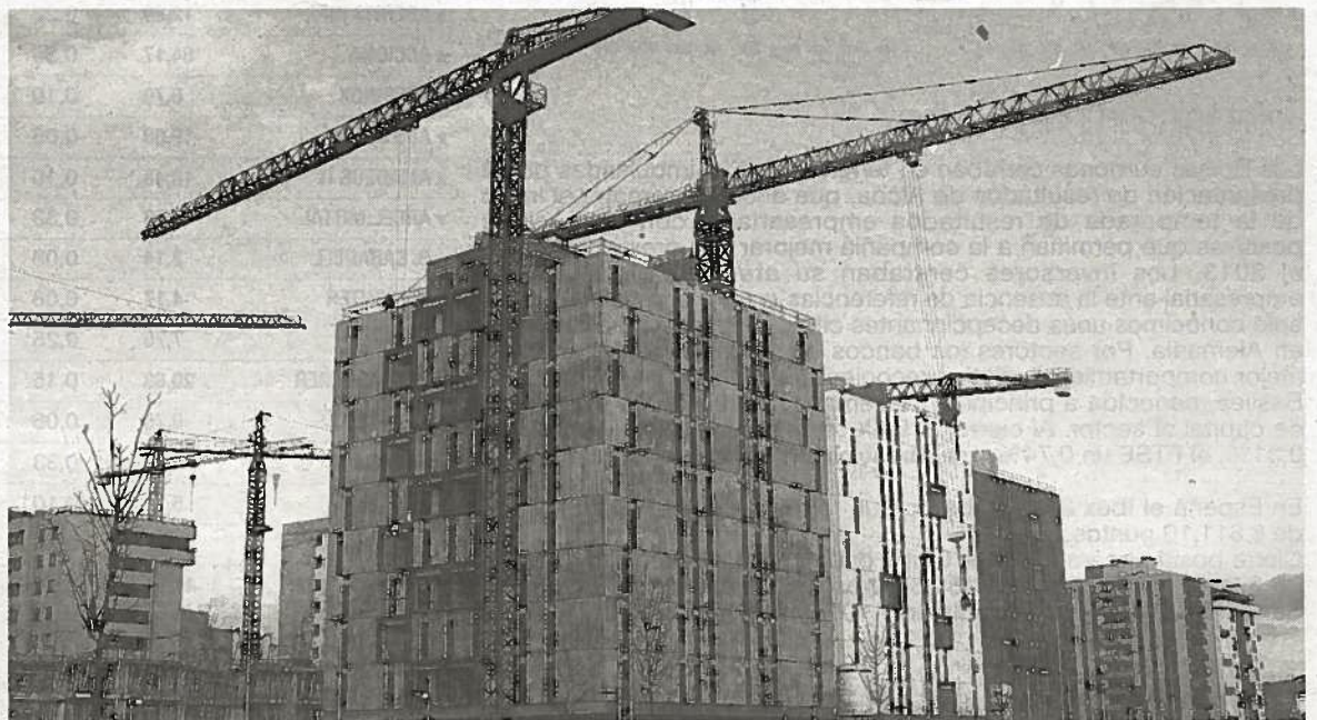
Bloques de viviendas en construcción de Nasipa en Erripagaña. FOTO: PATXI CASCANTE
