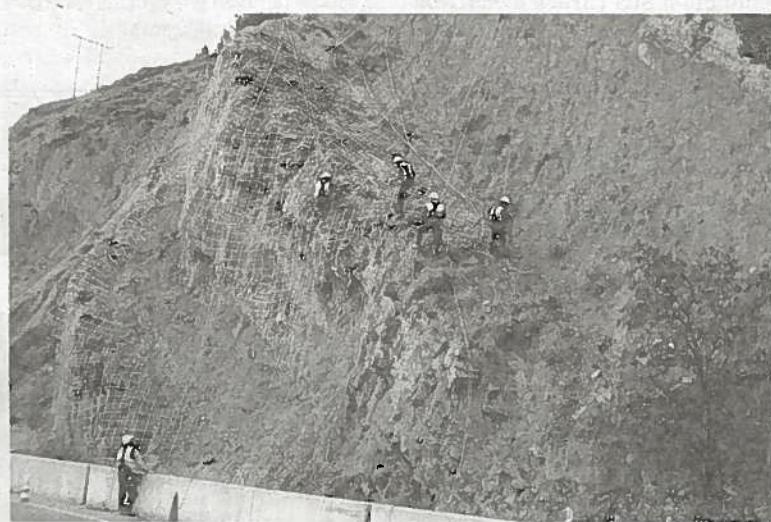
Varios obreros trabajan para estabilizar un talud en Sangüesa. FOTO: D.N.
