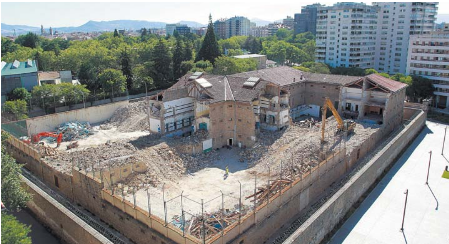
Imagen tomada desde la Audiencia Provincial el viernes, donde se aprecia que la demolición avanza a buen ritmo.
