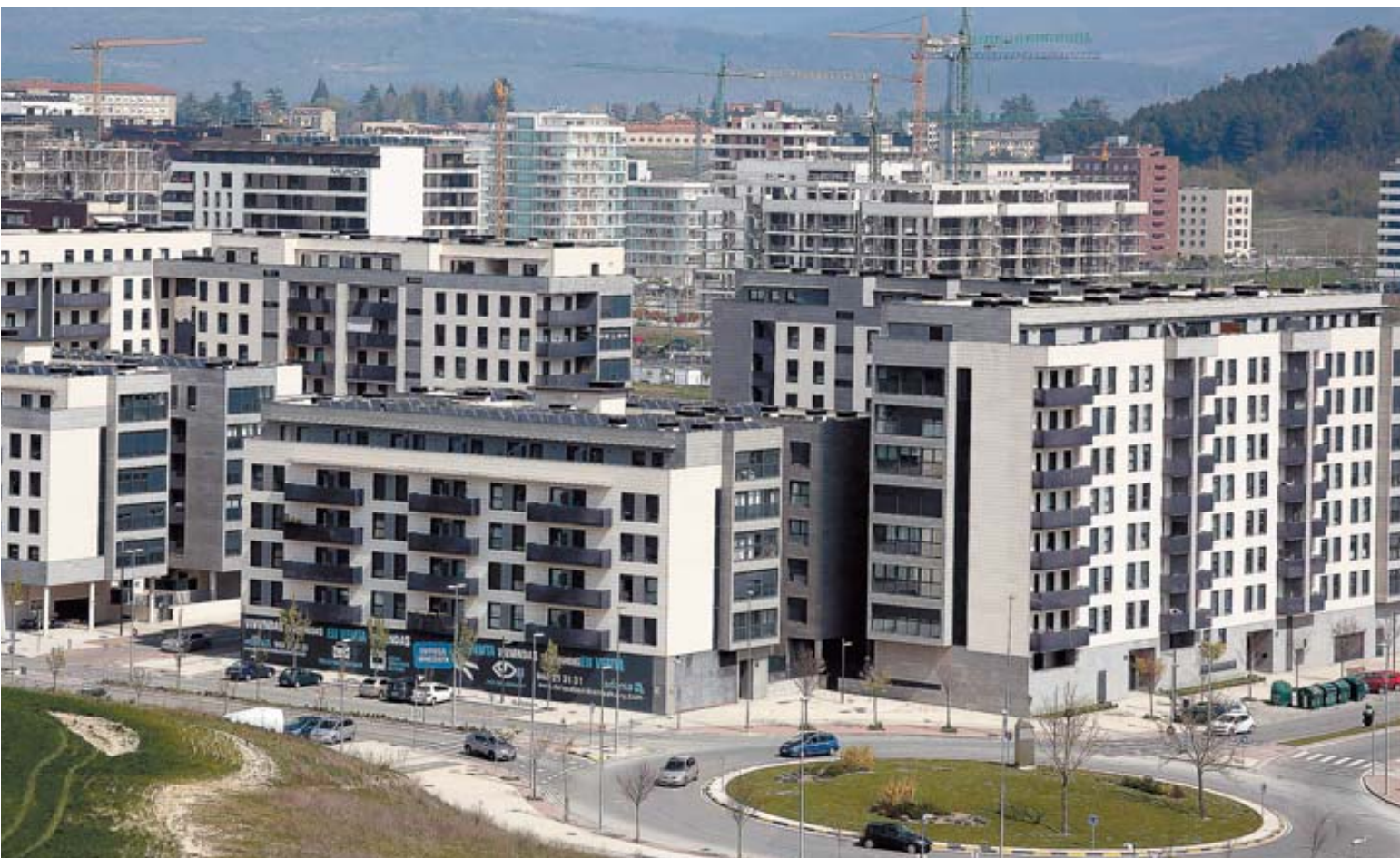
Imagen de edificios del Soto de Lezkairu, en Pamplona.
