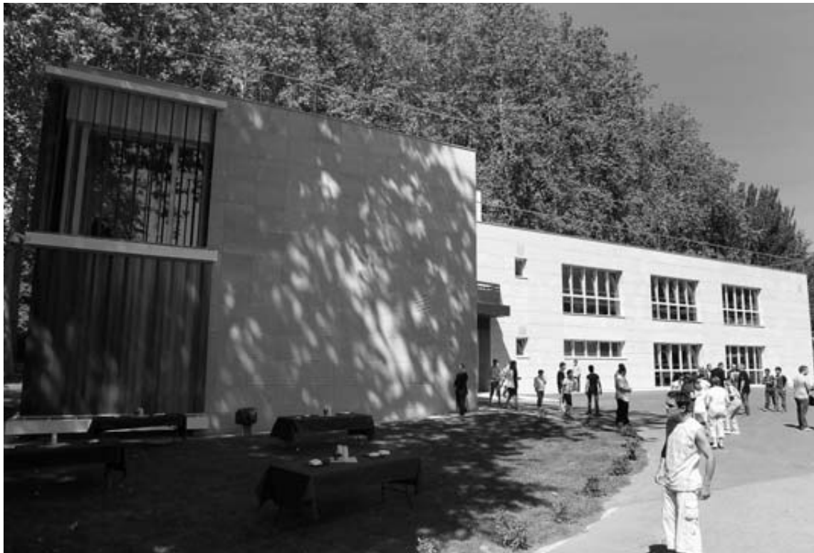
El nuevo edificio que acoge el Centro Ocupacional, ubicado a la izquierda del colegio El Molino.
