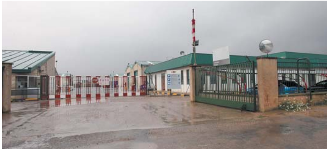
Una imagen exterior de las instalaciones de la fábrica de Dow Chemical en Ribaforada.
