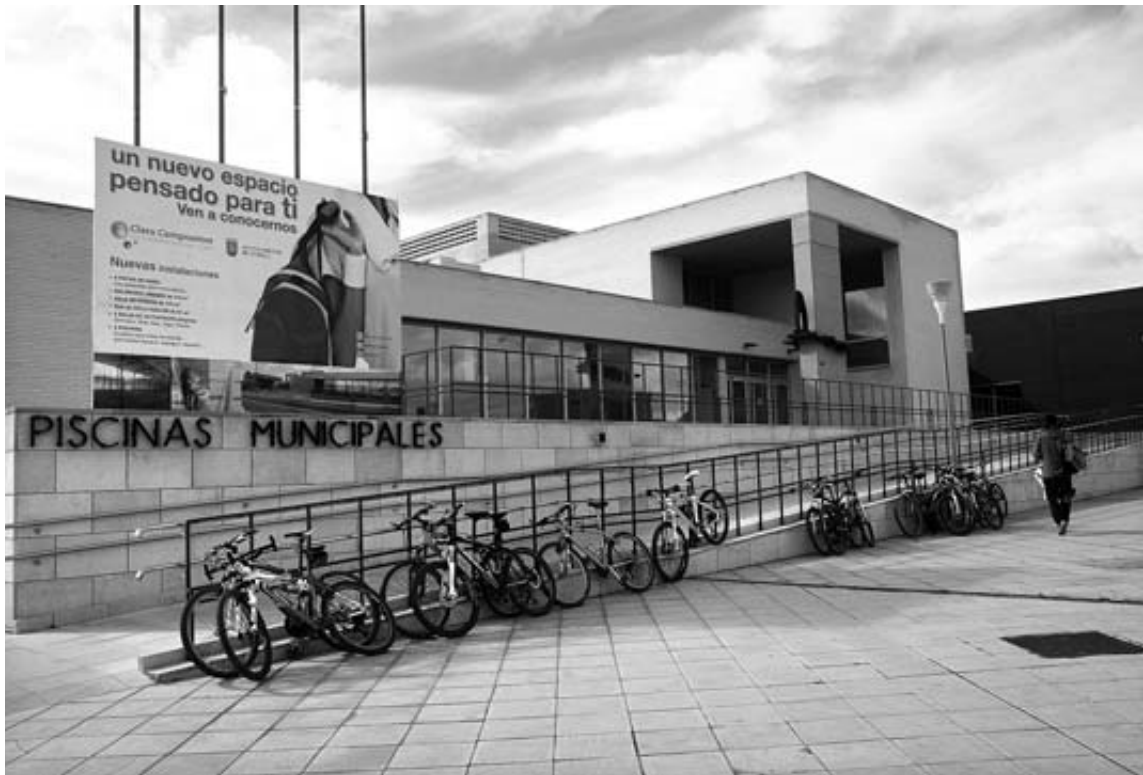
Vista actual del edificio que acoge la piscina cubierta municipal de Tudela.
