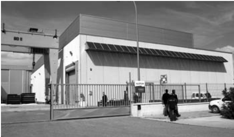
Varios trabajadores ante las instalaciones de Alstom en Buñuel. ARCHIVO
