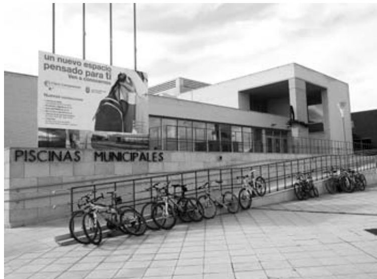
Edificio que acoge la piscina cubierta municipal de Tudela.
