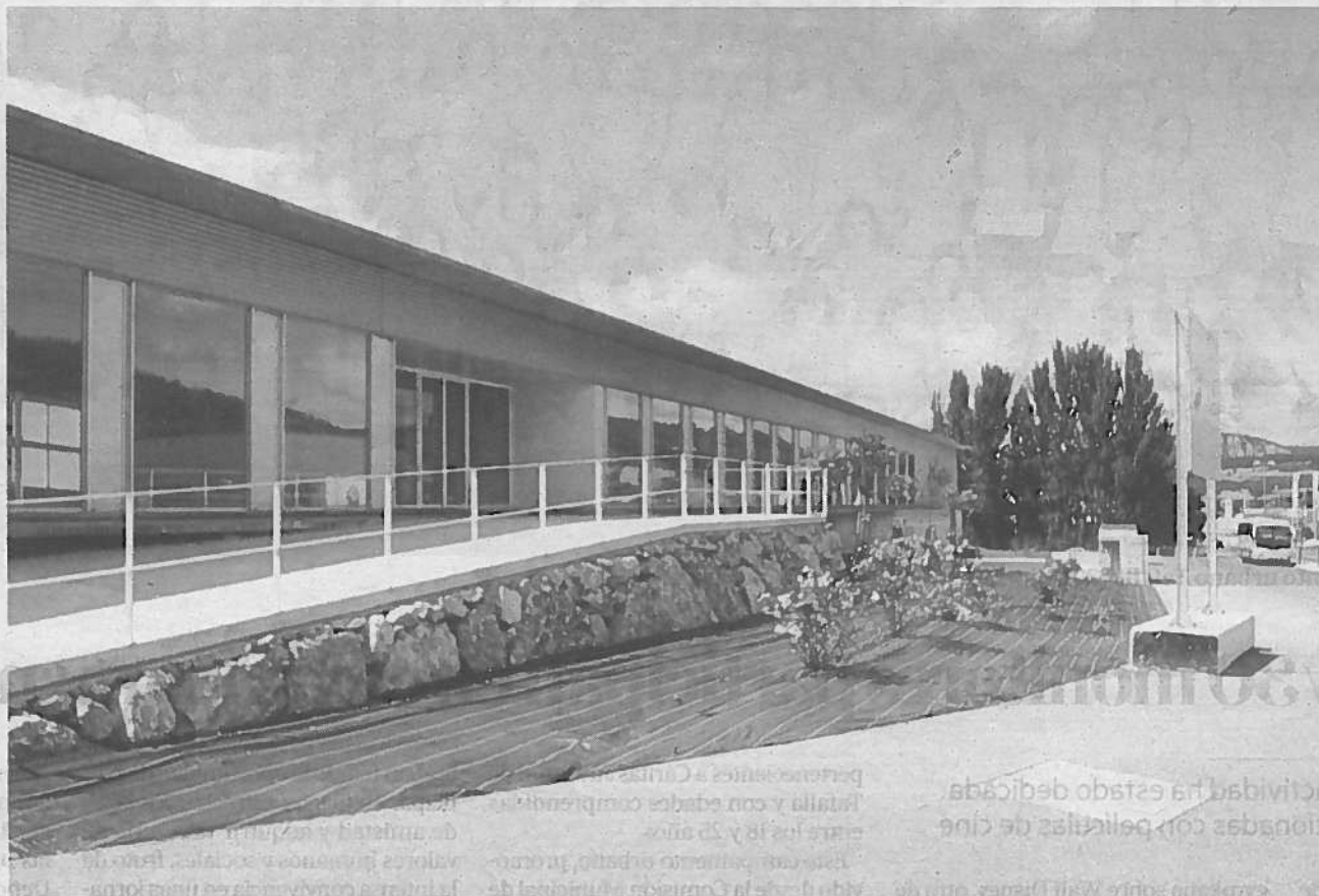
Vista general que presenta el edificio de la escuela taller, cuya construcción ya está terminada. Foto: C. Solano
